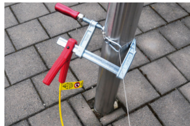
Erdung am Mast mit Hilfe einer Schraubzwinde
