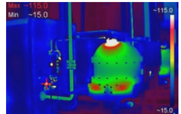
Überprüfung mechanischer Zustände
