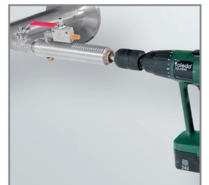
Anbohren unter Druck mit der CS Bohrvorrichtung
